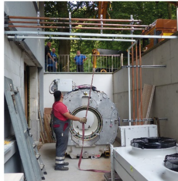
Abbildung 1: In den vergangenen Wochen wurden umfangreiche Umbauarbeiten an der KMT durchgeführt. - Foto: KMT
